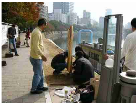
命名柱の設置作業風景、元安橋の遊覧船乗り場付近(11月2日) 手前は「灯和の径」モニュメント、通りの愛称は「8月6日通り」
